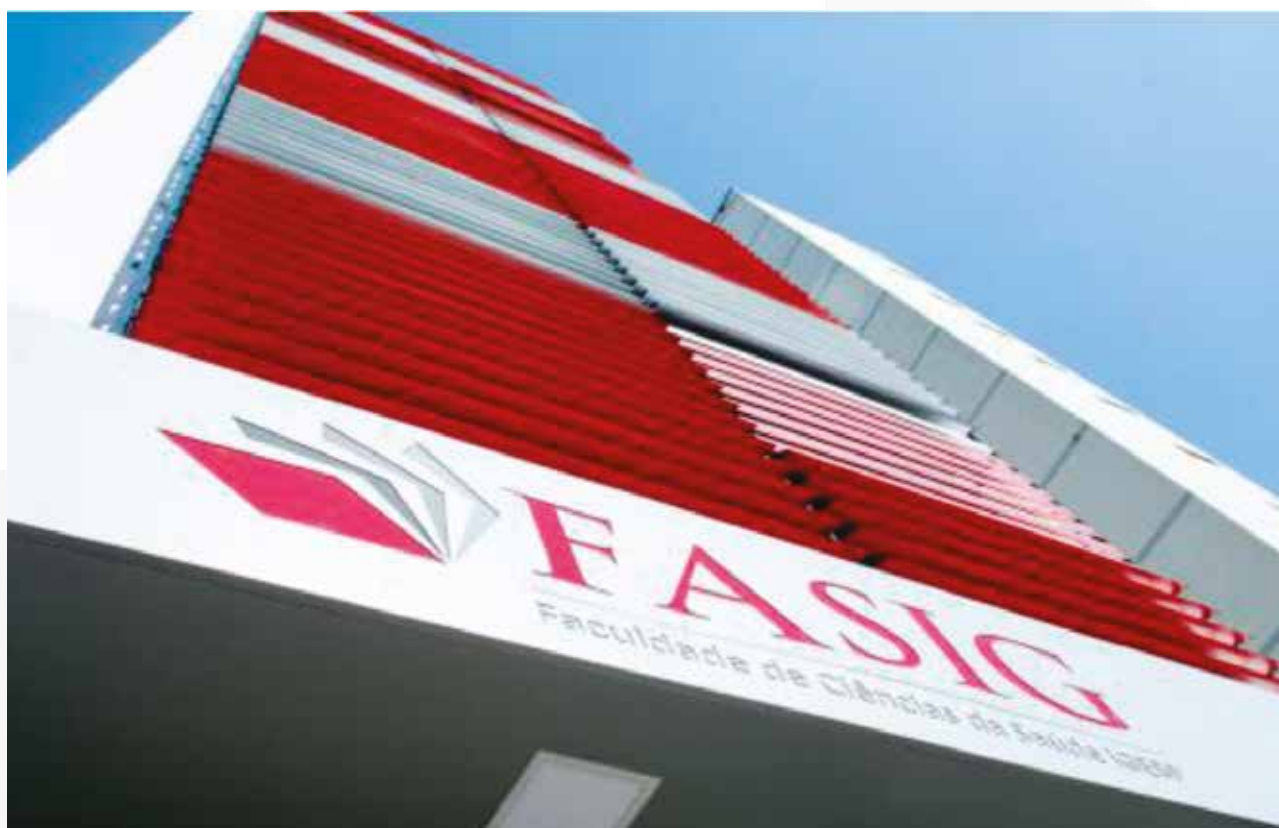
FIGURA 11: FOTO FRONTAL PRÉDIO DA FACULDADE DE CIÊNCIAS DA SAÚDE IGESP
